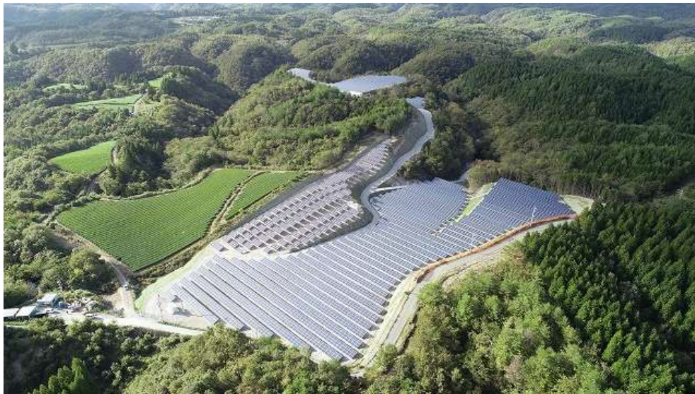
大分県中津市の太陽光発電設備
